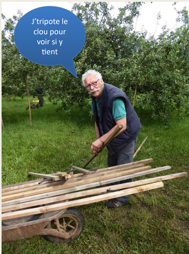
Pose des étais ce 8 juin
